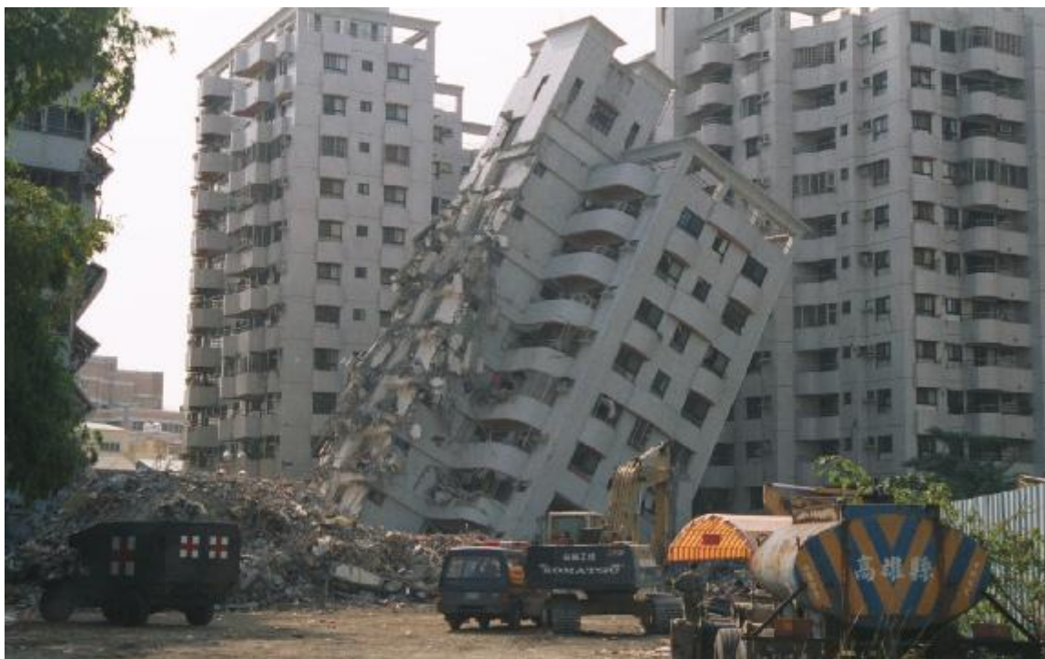
Рис. 8.1.2. Разрушение высотных зданий землетрясением
