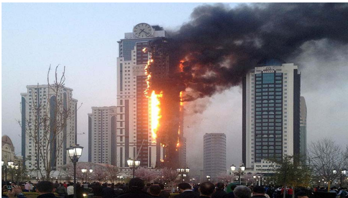
Рис. 7.2. Пожар в высотном здании
